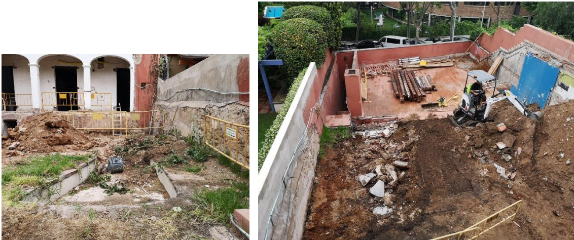
Figuras 40-41. Localización del estanque y su desmontaje
