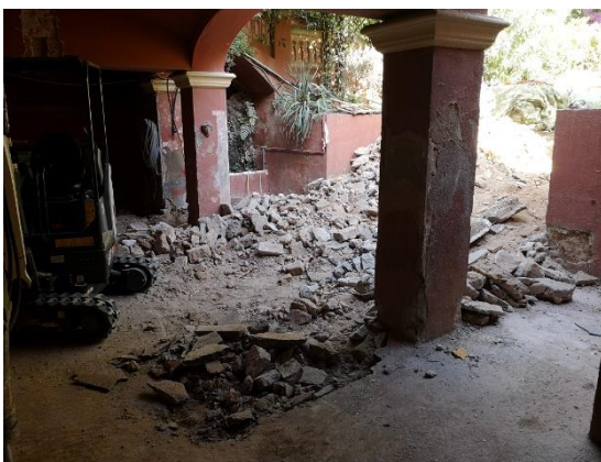
Figuras 56-59. Detalles del proceso de desmontaje de estructuras previas y aparición de alineamientos de piedra de la fase anterior.
