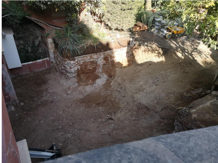
Figura 61-63. Detalle zona de acceso y desmontaje de los arriates laterales
