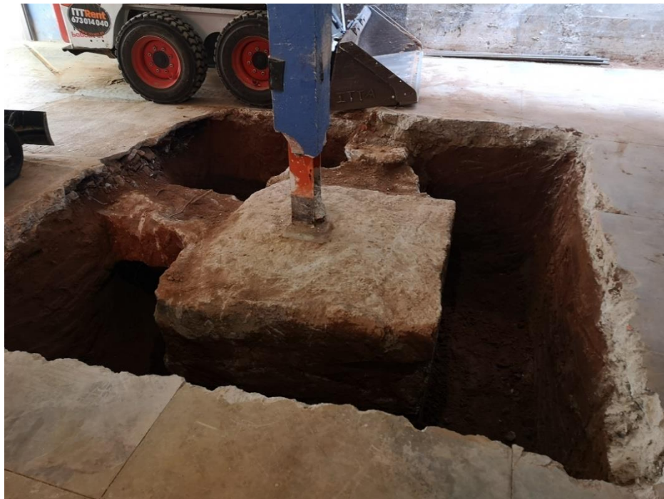
Figura 72. Detalle del proceso de excavación de la zapata y elementos adicionales
