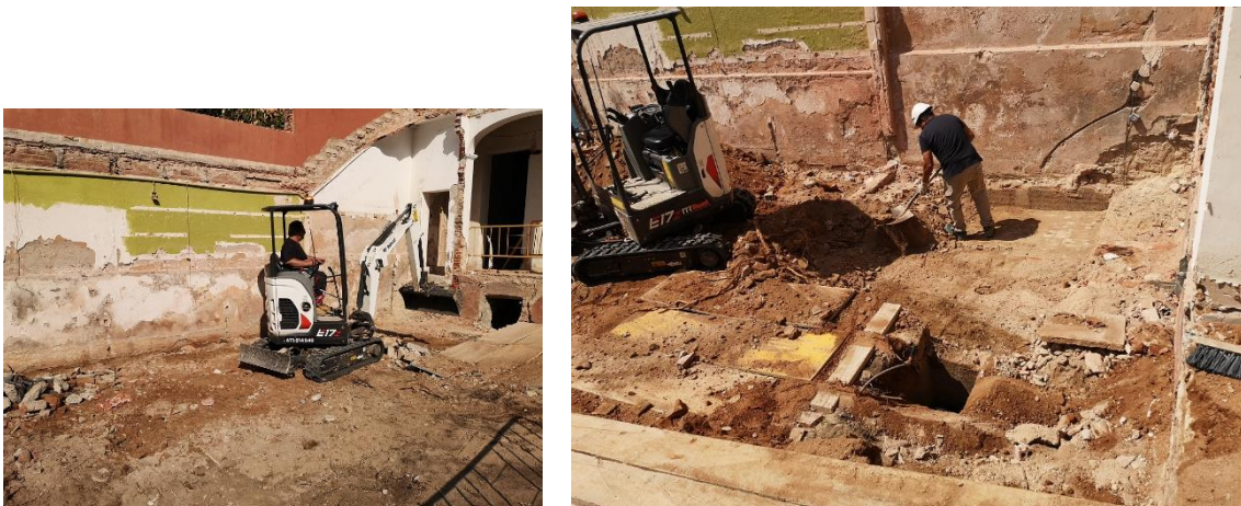
Figuras 30-31. Trabajos de limpieza inicial y documentación de cisternas y pavimento
