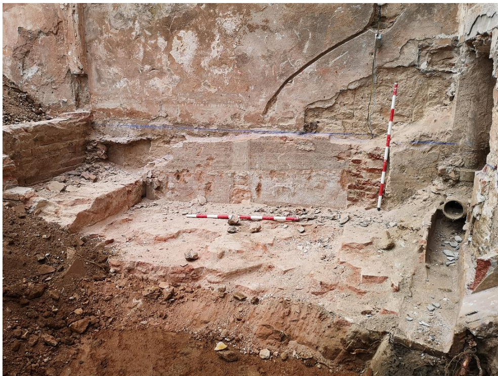
Figuras 37-39. Proceso de desmontaje de las estructuras del interior de la zanja
