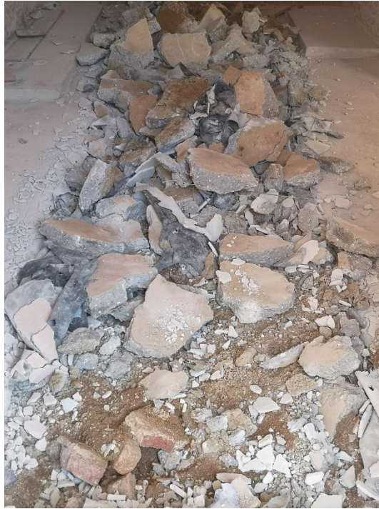
Figura 9. Zanja 1: inicio de los trabajos
