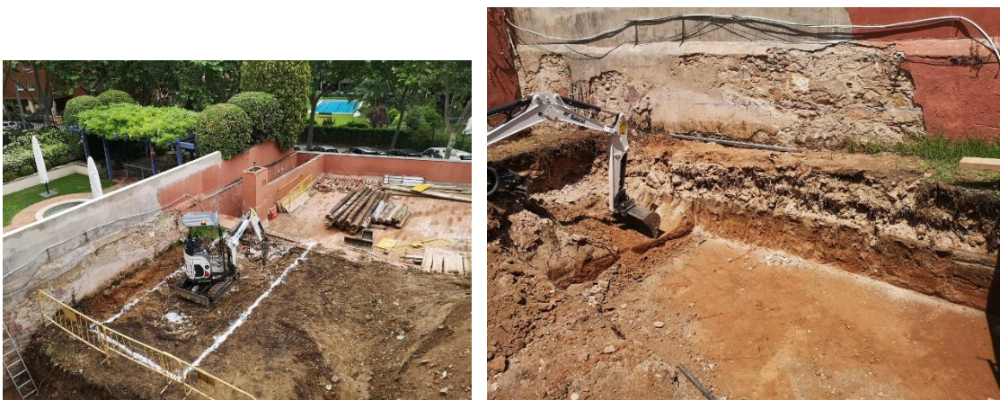
Figuras 42-43. Perímetro de la piscina y estratigrafía general del rebaje
