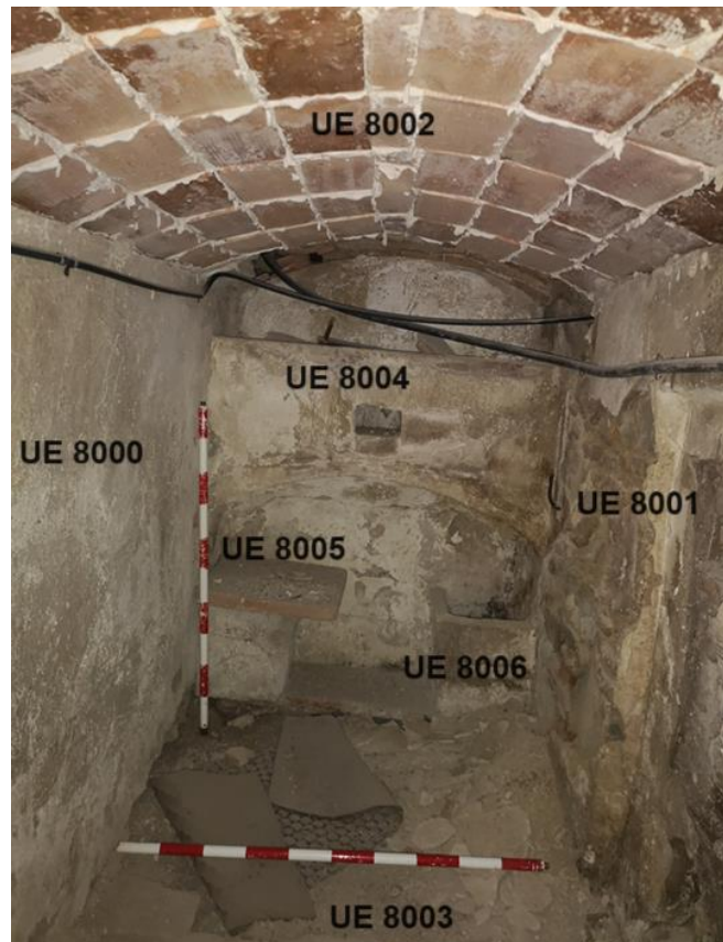
Figura 51. Extremo este con las unidades constructivas diferenciadas
